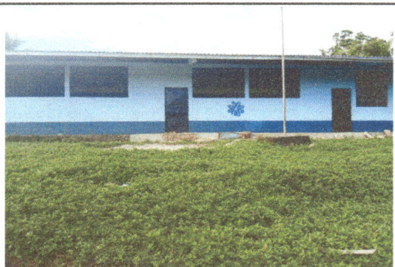
Terminación de reparación y pintada de las puertas.
