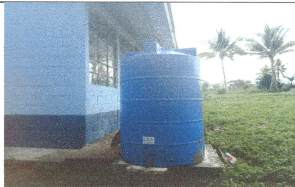
Colocación de rotoplas en su base.
