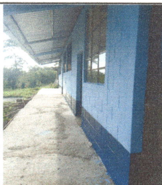
Terminación de reparación de piso corredor de la escuela.
