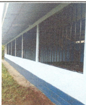
Terminación de pintada de balcones.
