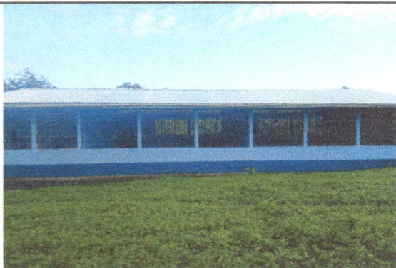
Culminación de pintada de paredes y balcones.
